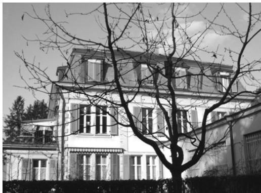
Malantaŭa flanko de la domo Museumsstrasse 14. Ĉi tiu domo estis konstruita en 1896 kaj estas konsiderata kiel protektinda konstruaĵo (fonto: Bauinventar der Stadt Bern; fotis A. Künzli)
